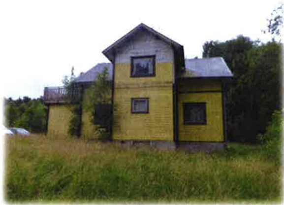
Befintlig byggnad idag
