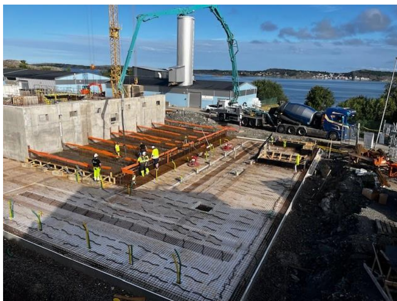
Om- och utbyggnad av reningsverket i Ellös
