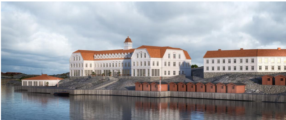
Vit eller nära vit färgsättning gör anläggningen mer synlig på håll. Bild TB-gruppen/INOBI.
