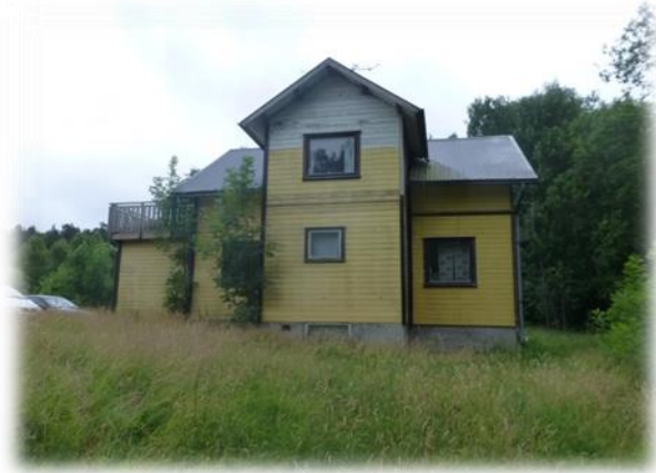
Befintlig byggnad idag
