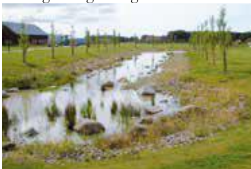
Dagvattendamm med vattenspegel (Svenskt vatten P110)
