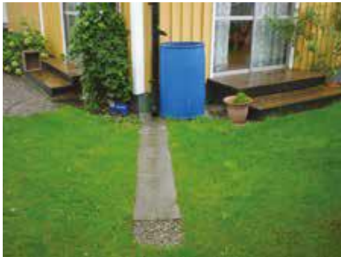
Stuprörsutkastare med rännal (Svenskt vatten P110)
