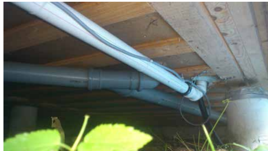
Ledningsdragning kryppgrund.
