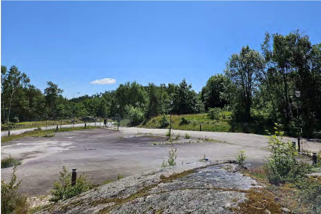
Figur 10: Sydöstra och mellersta delen.
