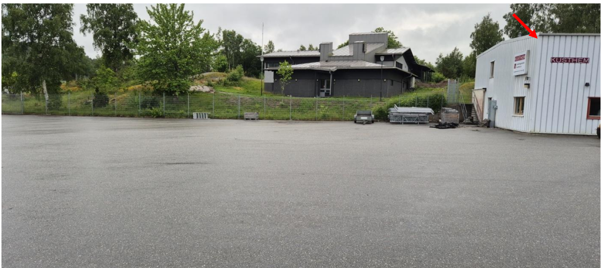
Figur 6-2 – Översikt av den befintliga asfalterade ytan, bild tagen inom Varekil 1:177 i riktning syd. Referenspunkt markerad med röd pil.
